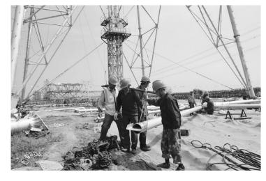
8月18日,河南送变电 建设有限公司组织员工在河 南省上蔡县无量寺乡付刘 村,对驻马店至南阳1000千 伏特高压交流输变电工程线 路工程1标段IS096铁塔进 行组立。目前,该条线路1 标段已全面进入铁塔组立施 工阶段,该标段自3月15日 开工以来,国网上蔡县供电 公司与当地政府相关部门积 极协调,全力做好特高压工 程建设属地协调工作,为整 个特高压工程的有序推进保 驾护航。线路全长188.4千 米,新建同塔双回铁塔377 基,线路途经驻马店(上蔡、 西平和遂平)、平顶山(舞 钢)、南阳(方城)3市5县。
