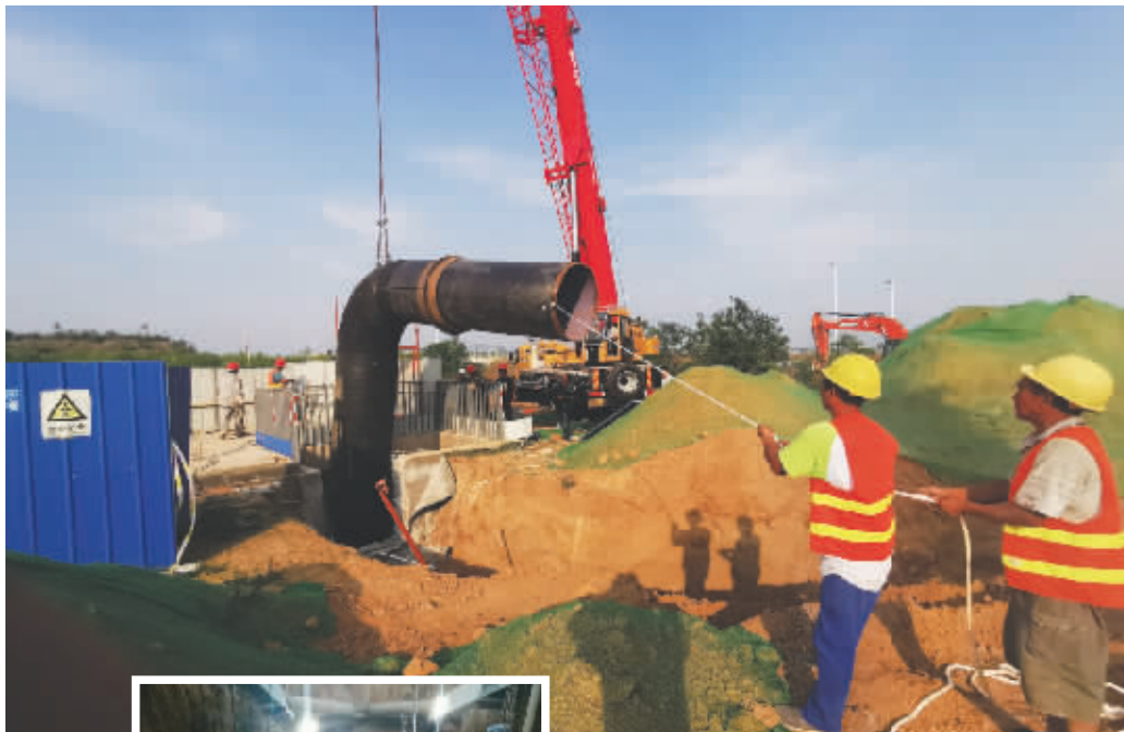
输水管道下穿南水北调干渠管廊，工人正在对出廊管道进行吊装作业
