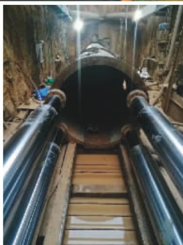
通航路直径1.4米钢管顶进工作现场
