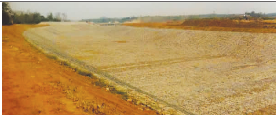
水库导流明渠
