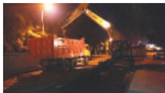
| 老城区部分路段主管网正加紧昼夜施工
